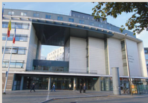
Sur la terrasse, des locaux tec-iques ont été créés pour abriter le nouveau matériel de chauffage/ventilation/climatisation.
