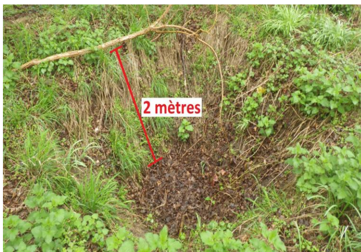
Figure 18 : Fontis de 2 m de profondeur sur 3 m de diamètre observé sur la rive de la Loire à Bou
