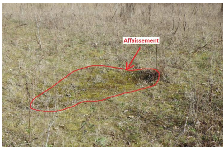
Figure 17 : Affaissement observé dans la commune de Bou proche de la Loire
