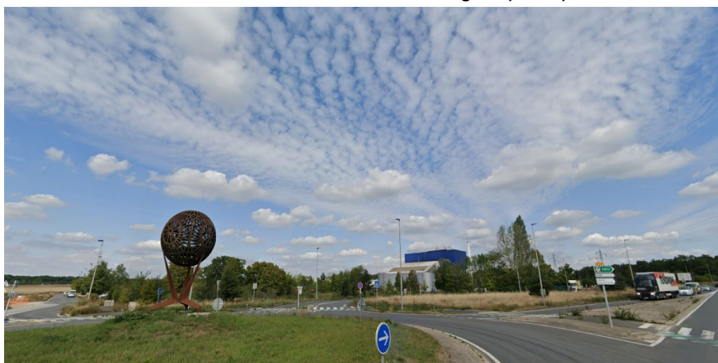
Unité de Traitement des Ordures Ménagères (UTOM)
