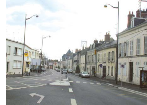
L'entrée du Faubourg-Bourgogne à partir des boulevards
