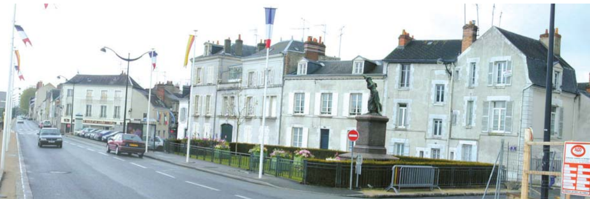
Quai du fort des Tourelles ; en contrebas, rue du Fort des Tourelles
