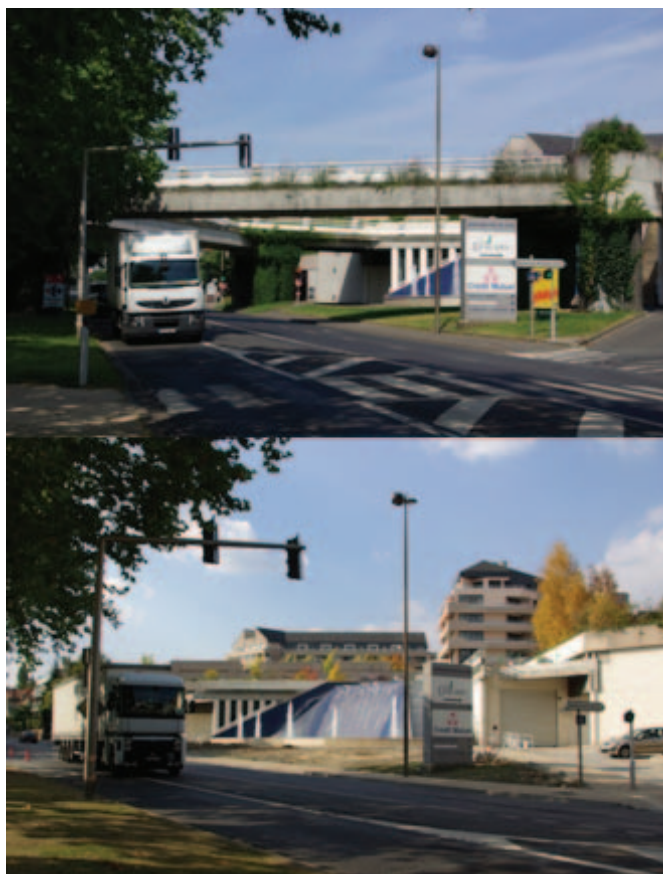
Le quai de la Madeleine, avant et après destruction de la passerelle
