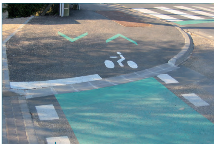
Marquages au sol du réseau cyclable.
